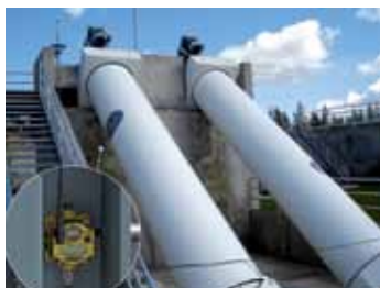
Kontrola průtoku v potrubí.
